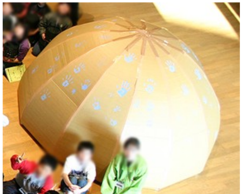
実際に製作した直径2.6m、12分割のダンボールドーム
